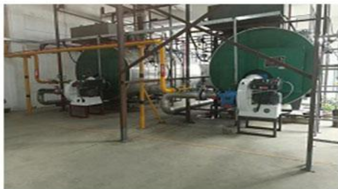
项目：中国建筑集团
